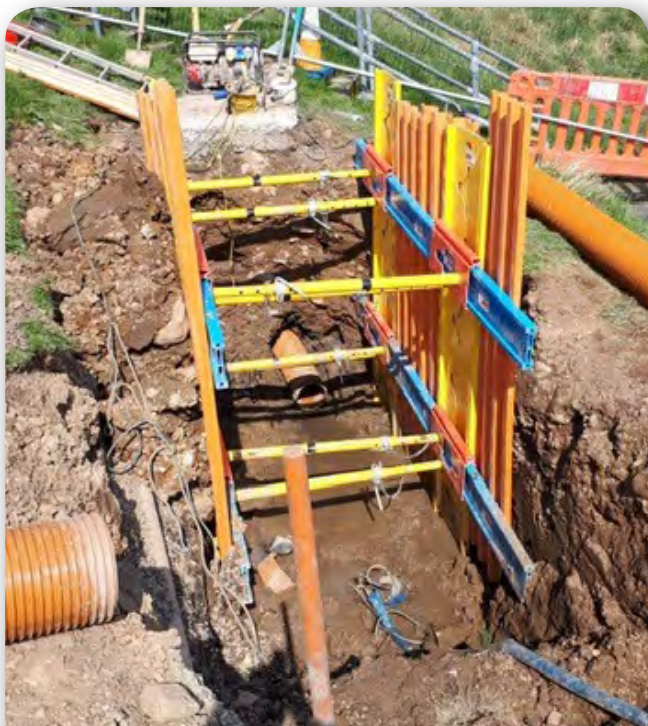
Installation du blindage dans des endroits difficiles d'accès.
