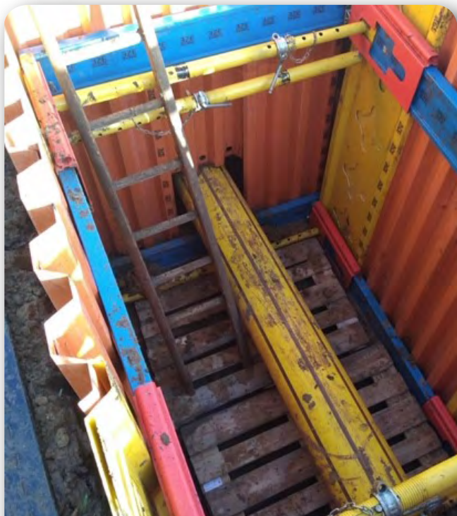
Fermeture aux 4 cotés et pose d'un plancher
