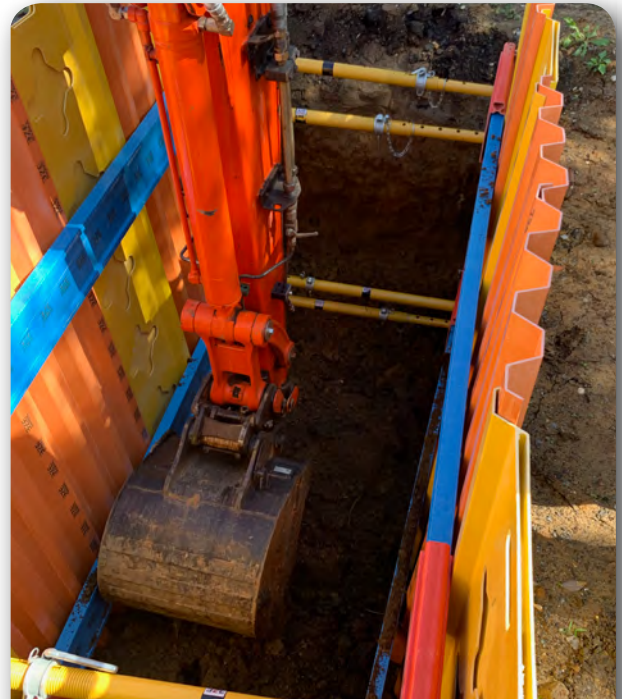
Accès aisé de la pelle lors de la pose par havage ou pour les opérations de remblaiement et compactage.
